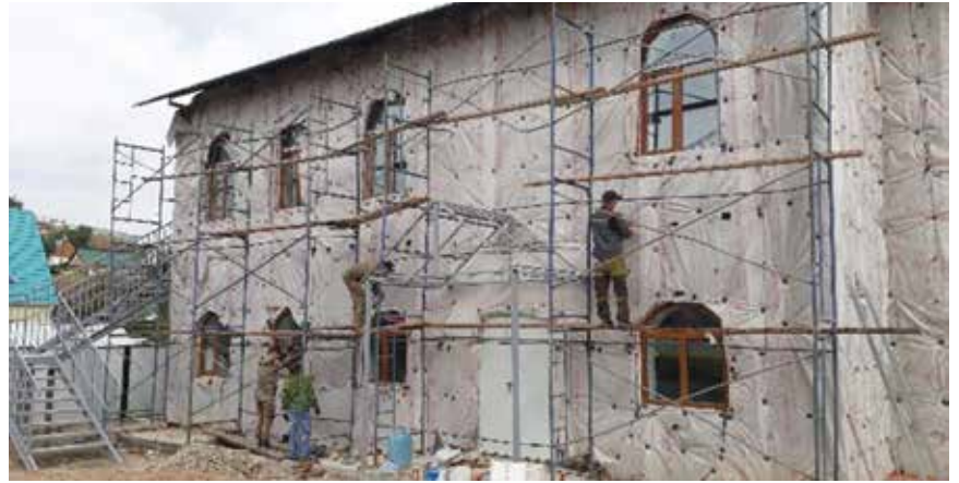
Ulan Uden kirkon julkisivupaneelien asennuksen valmistelua.
